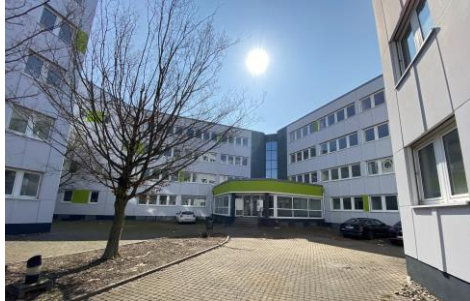
Peter-Sander-Straße 30, 55252 Wiesbaden (vorher)
